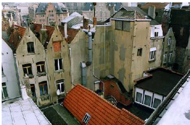
Rue Marché aux Herbes – îlot 12 - Transformations en intérieur d'îlot
