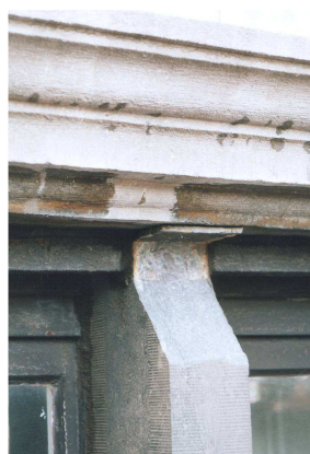
Différents états de dégradation et d'éclatement des pierres.
