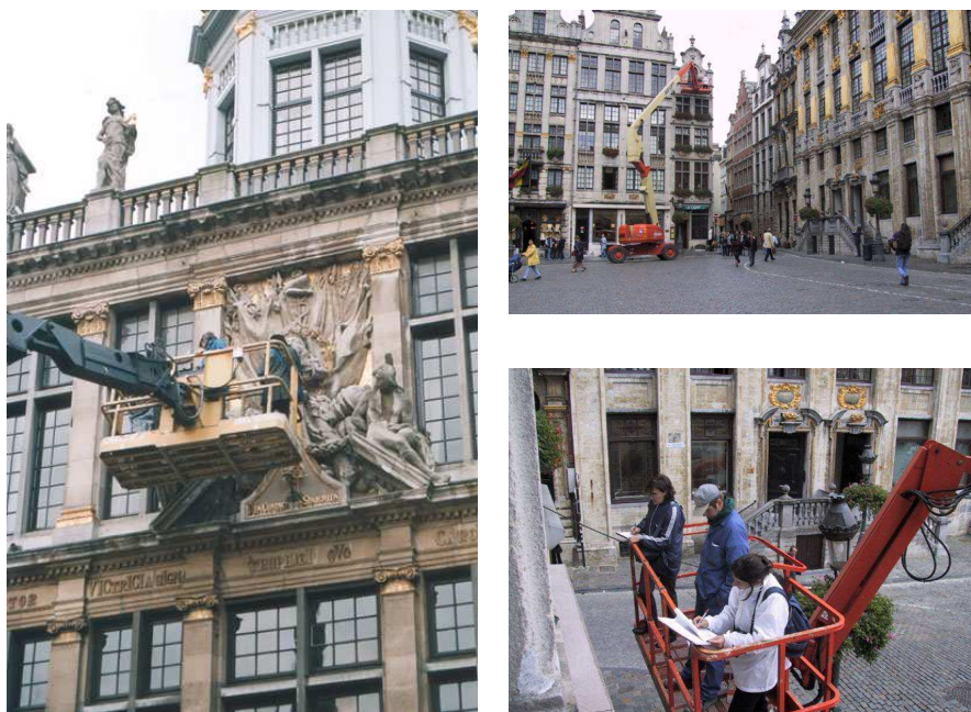
Inspections des façades à partir d'une nacelle.
