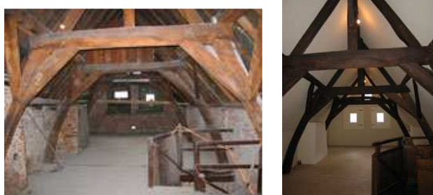
Bâtiment principal - grenier - avant et après restauration
