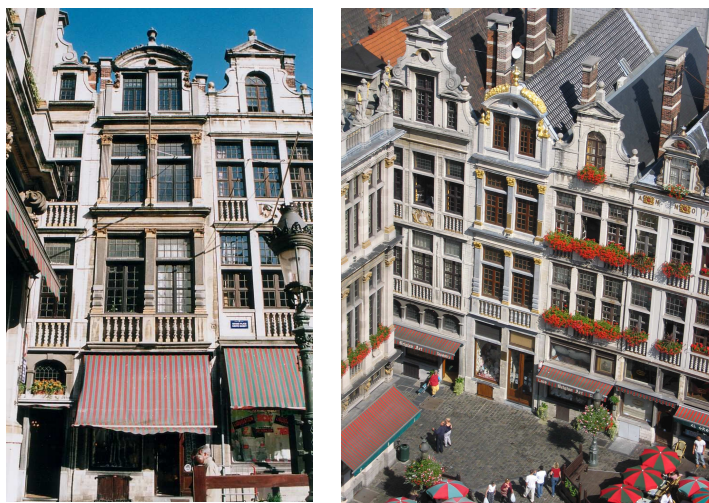
Maison L'Ane , Grand-Place n° 39. Etat de la façade – avant et après restauration.
