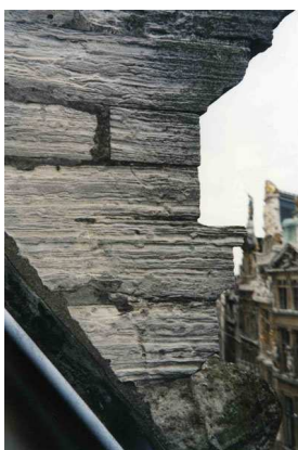
Différents états de dégradation et d'éclatement des pierres.
