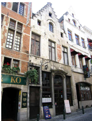
rue des Chapeliers n°s 18-20 pignon à gradins
