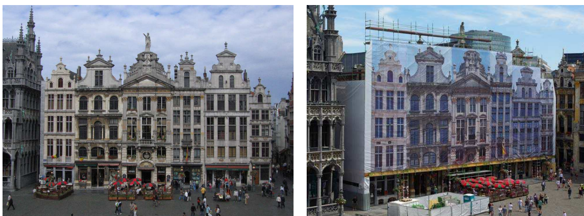
Le Cerf , Joseph et Anne , L'Ange , La Maison des Tailleurs , Le Pigeon et Aux Armes de Brabant , Grand-Place n°s 20 à 28. Etat des façades – avant et en cours de réalisation
