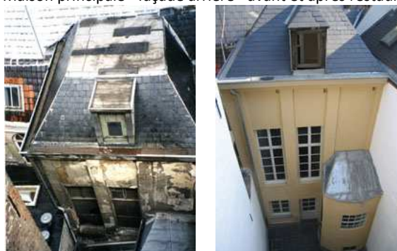
Maison arrière - façade principale - avant et après restauration
