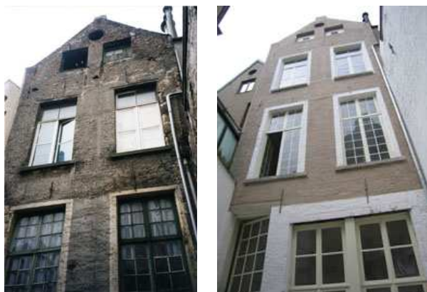
Maison principale - façade arrière - avant et après restauration
